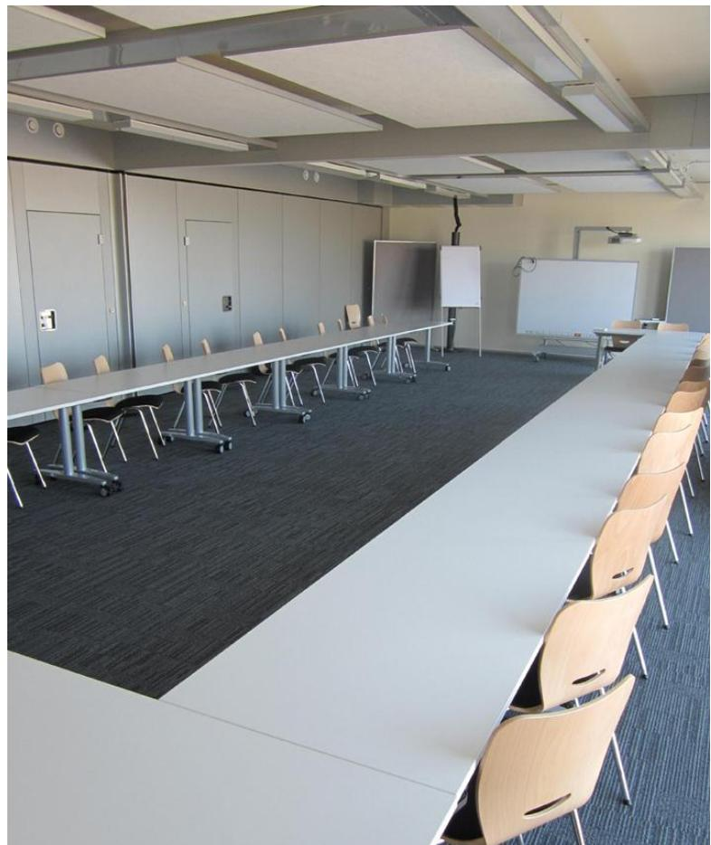
In den Seminarräumen sorgen an der Decke montierte Schallschutzelemente für mehr Sprachverständlichkeit
