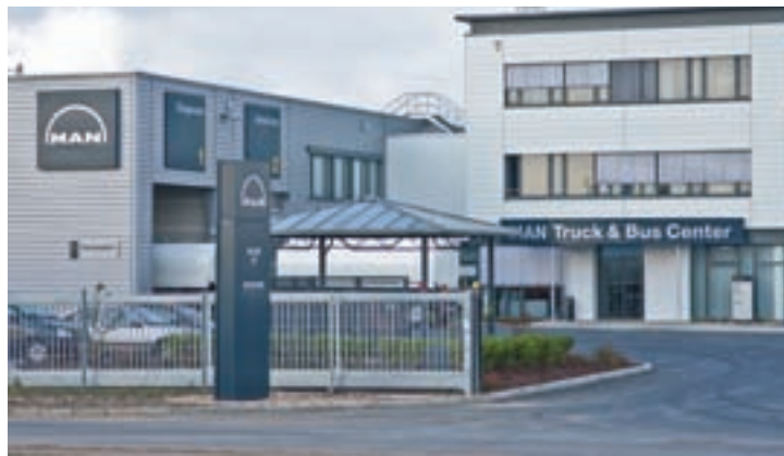
Hundhausen war Generalunternehmer beim Bau des MAN Truck & Bus Center Köln-Düsseldorf
